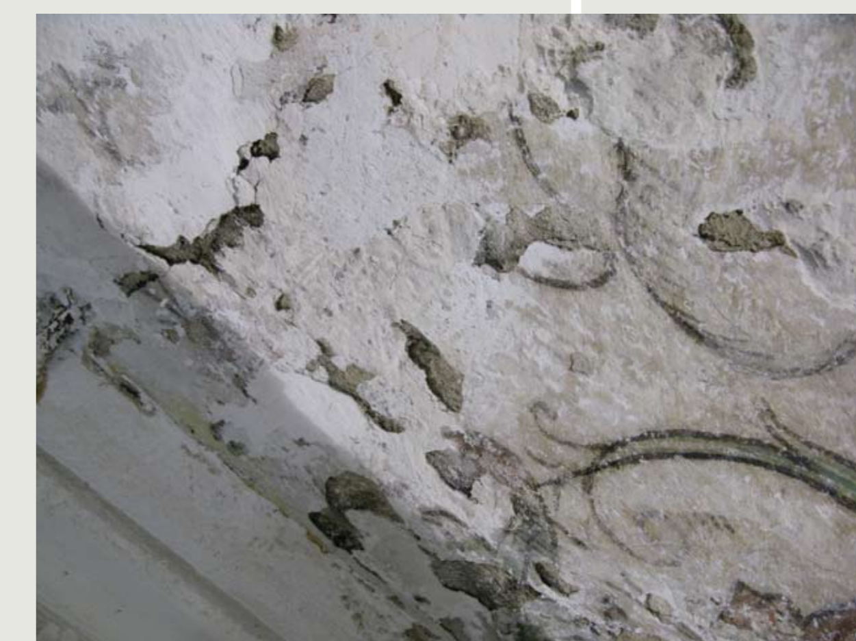
Beschaadigd pleisterwerk
