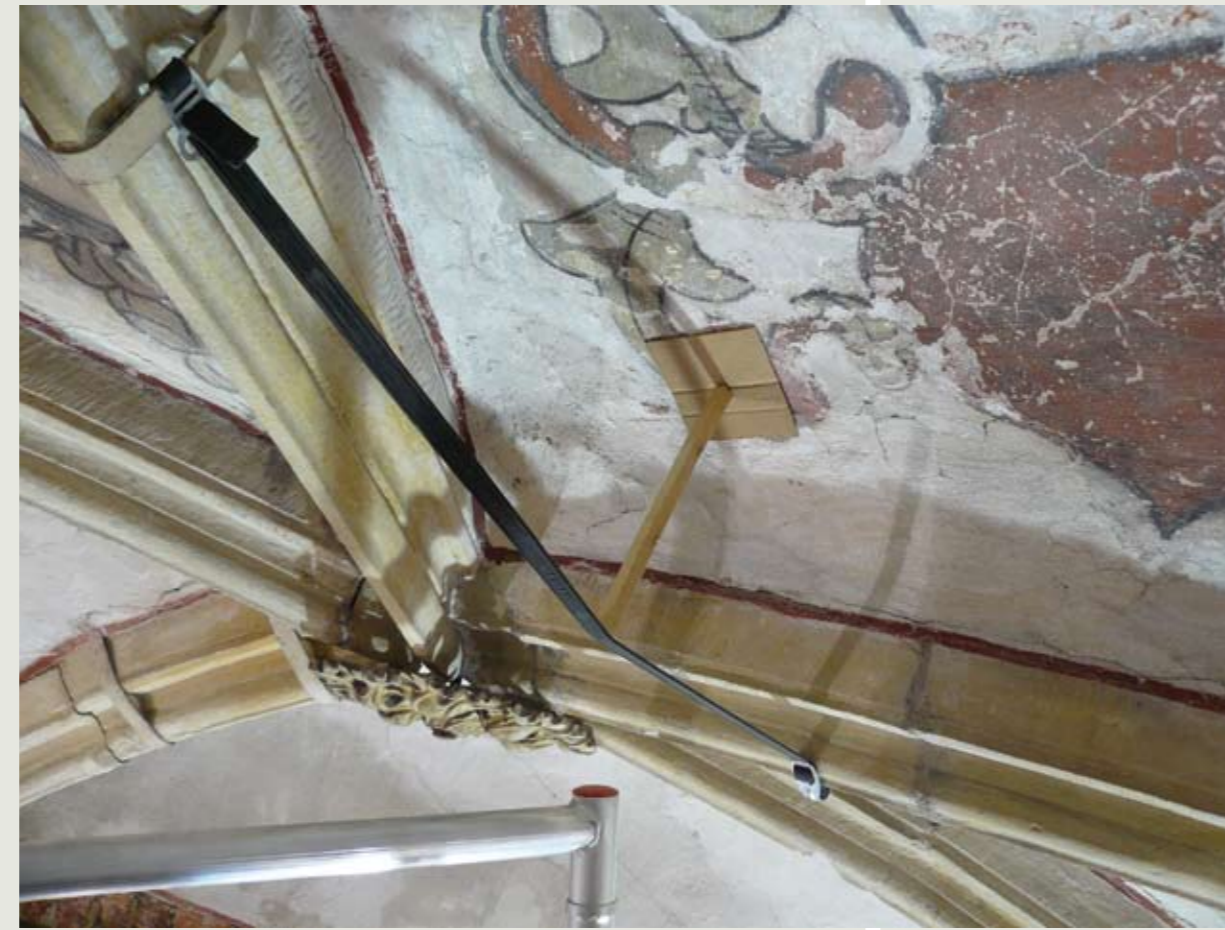
Injecteren en aandrukken los pleisterwerk
