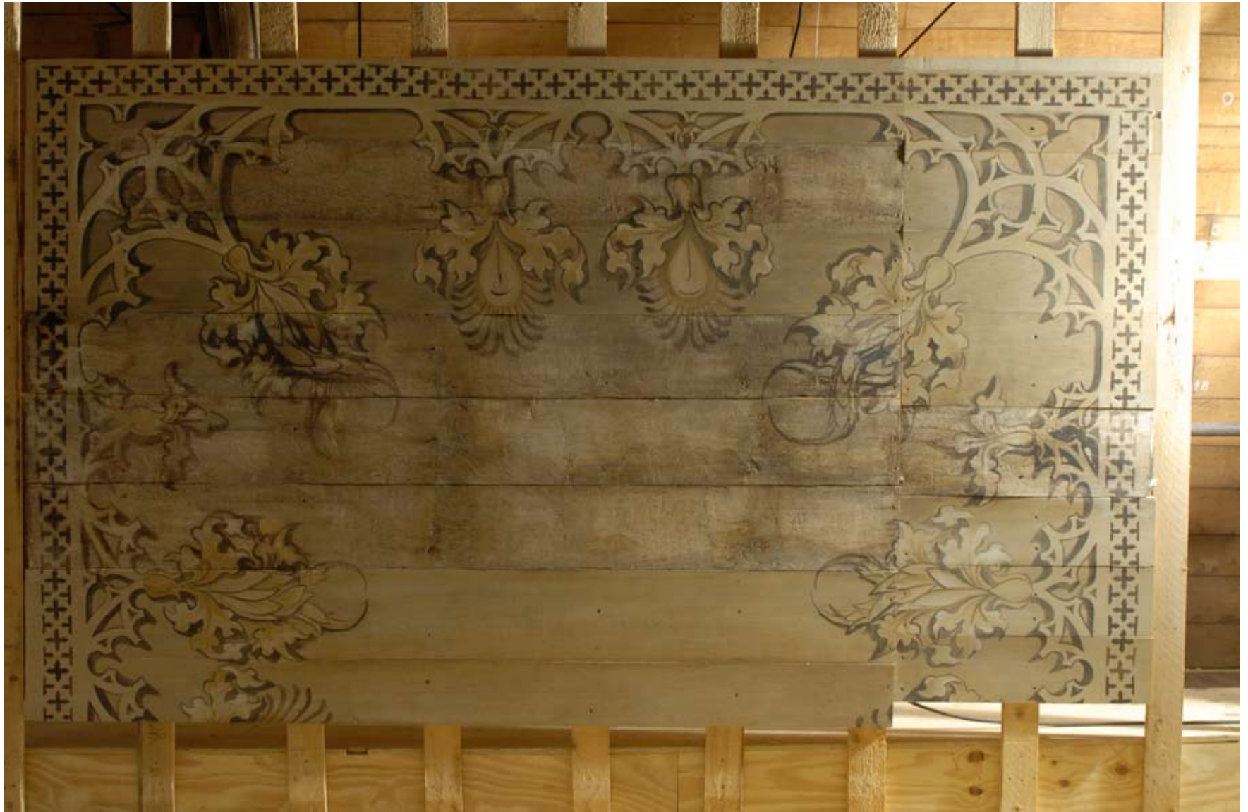
Afbeelding 55: Bovenkant van vak N2 op de bok. De kamversiering op de nieuwe planken gecompleteerd.
