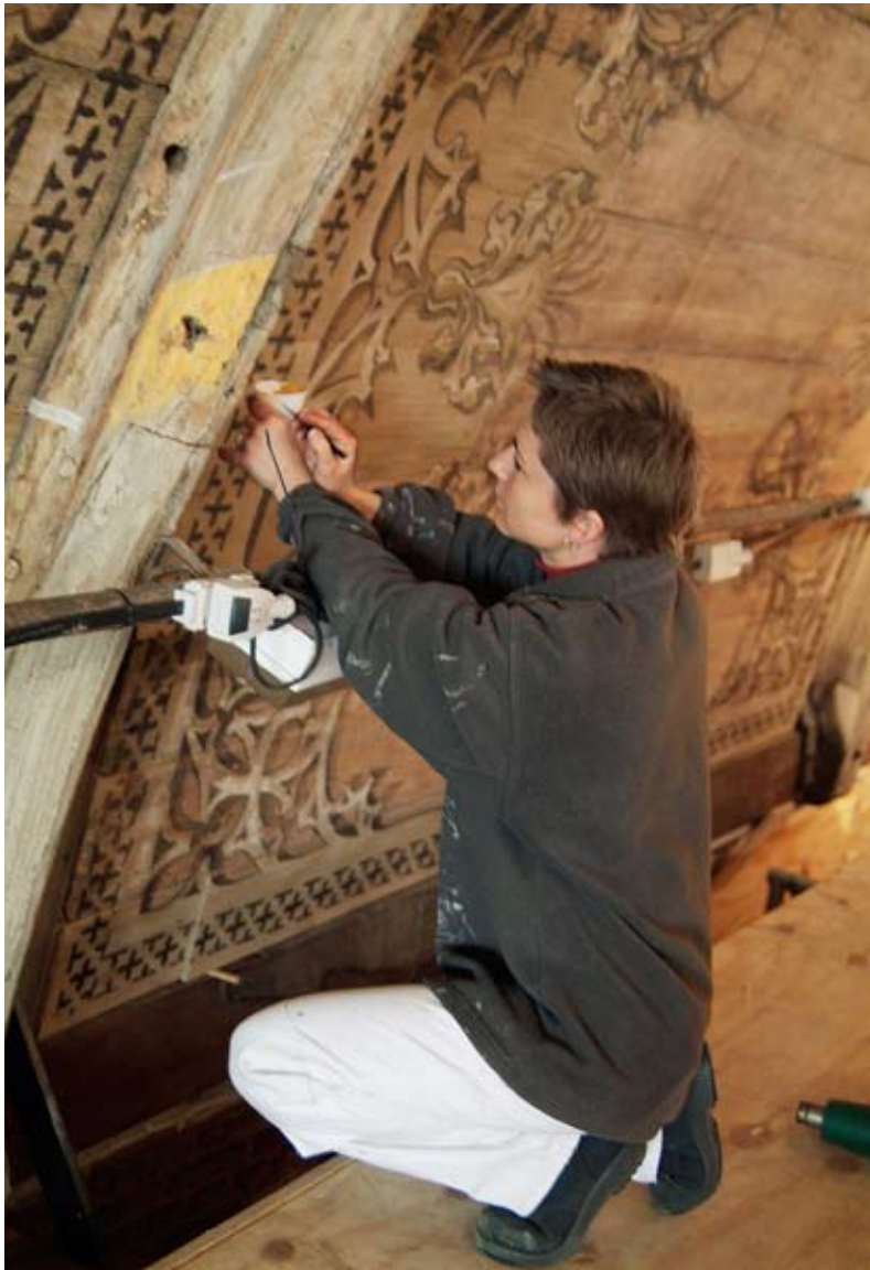
Afbeelding 46: Leonieke Polman begint met het inkleuren van de kepers op de ribben in het transept.
