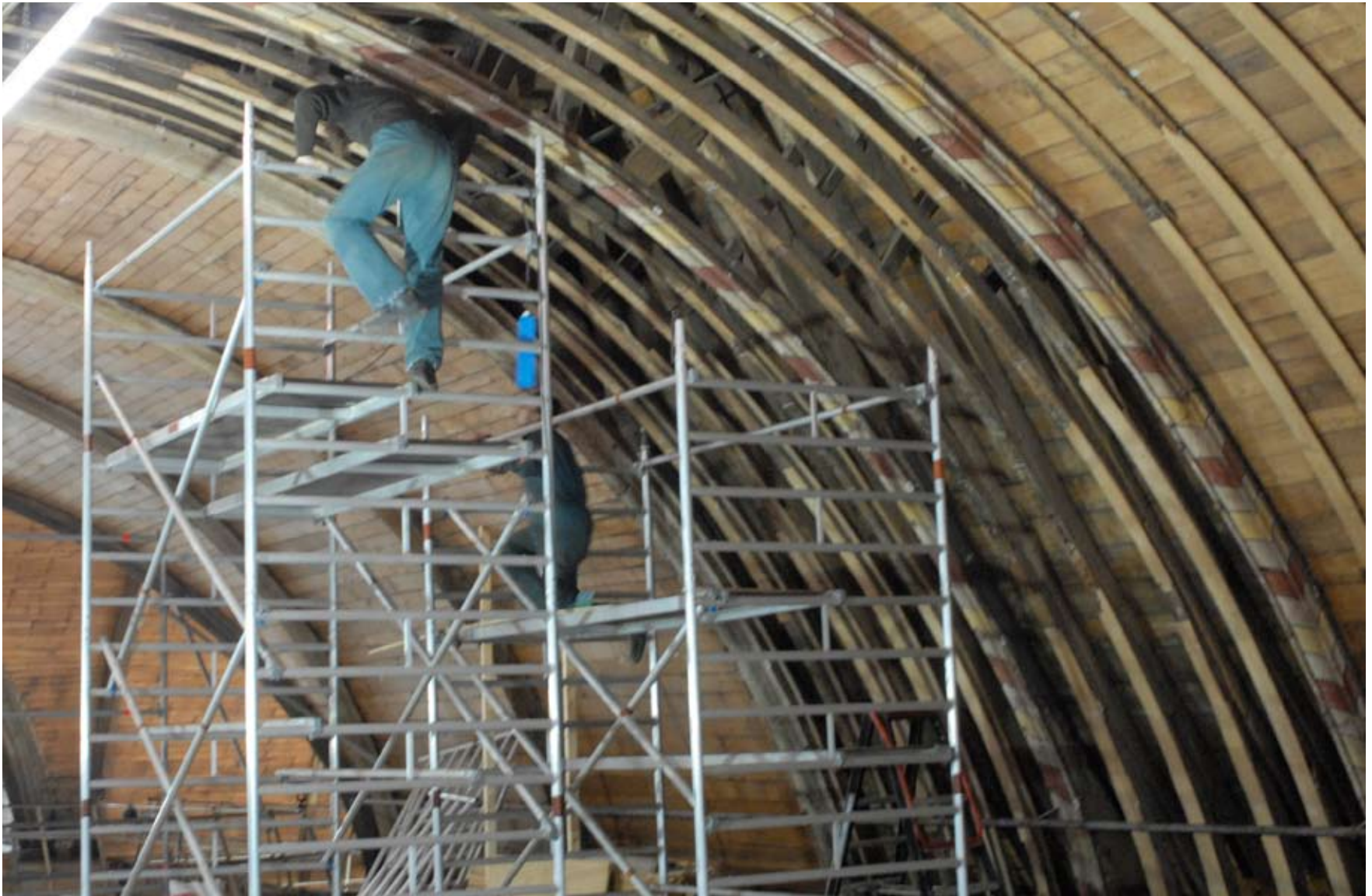
Afbeelding 63: De westelijke vakken C en D zijn geopend voor herstel van het gewelfhout en de bevestiging van het tussenbeschot.
