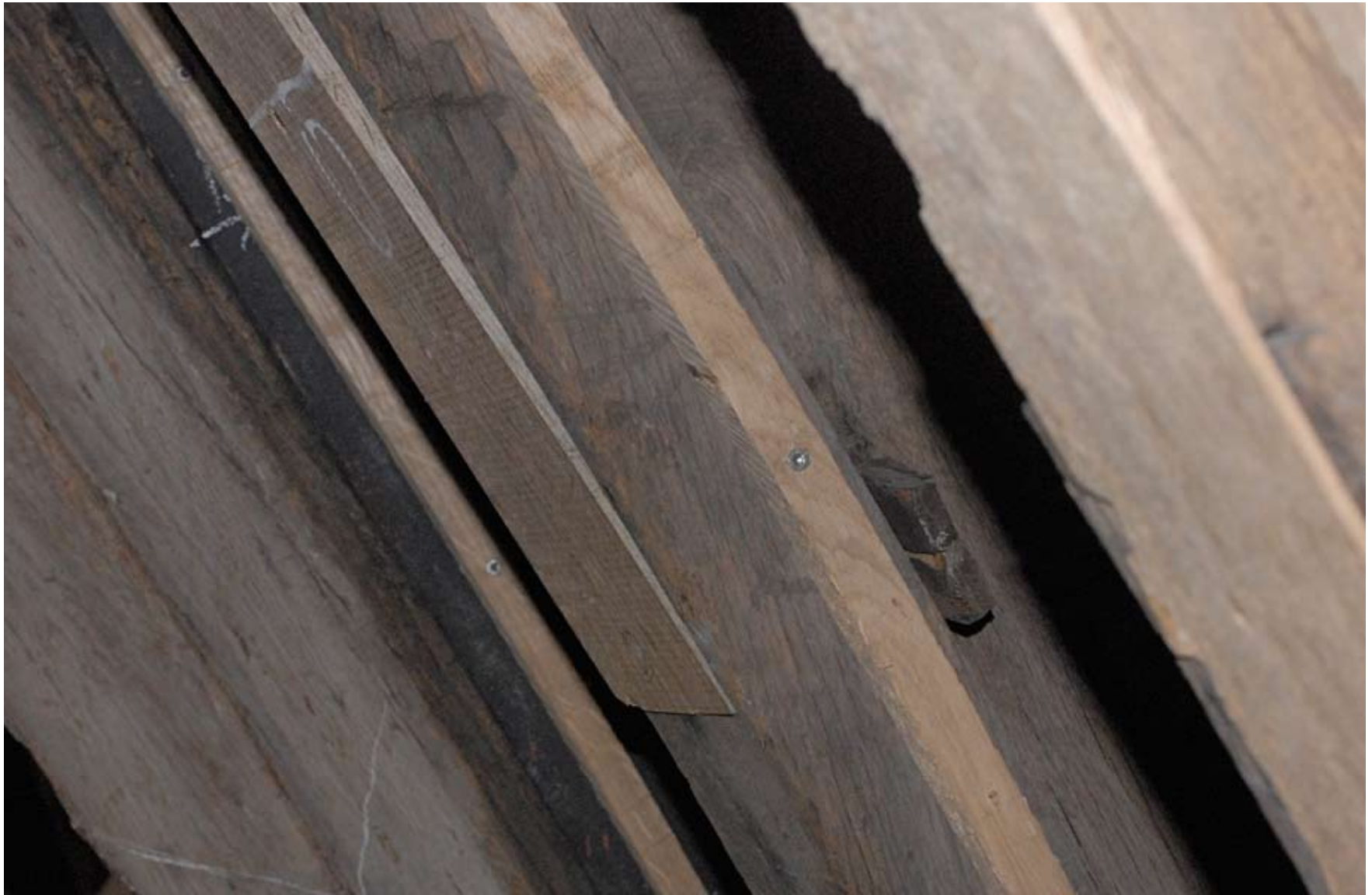
Afbeelding 61: Het gewelfhout verzwaaard met een eiken strook voor een optimale aansluiting van het terug te plaatsen oude beschot. Tegen de zijkant de eiken lat voor de bevestiging van het tussenbeschot.
