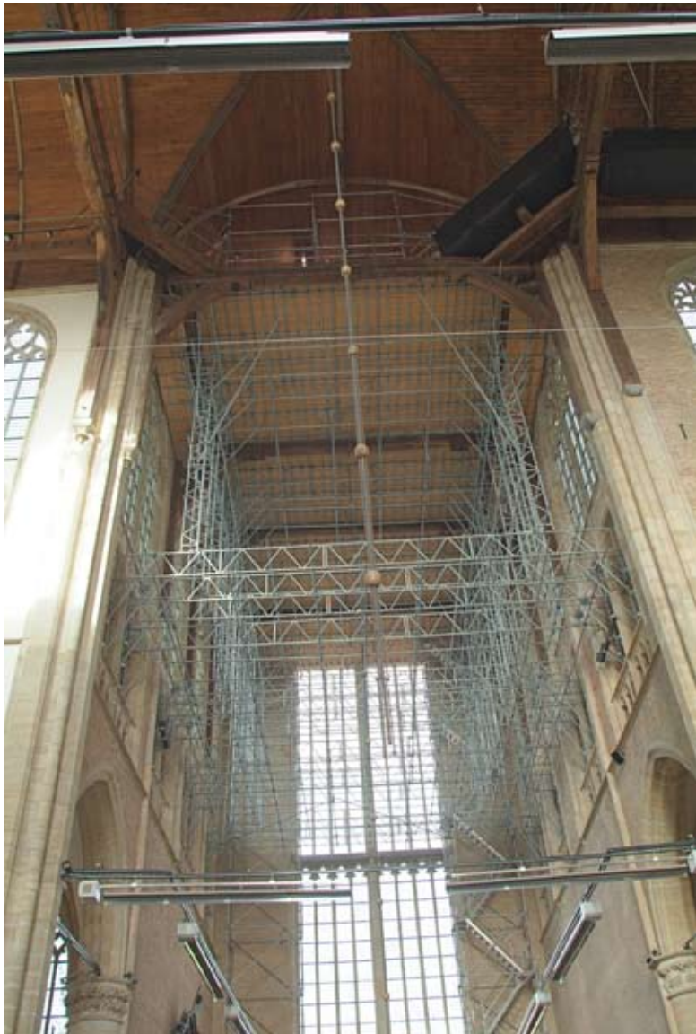
Afbeelding 56: De steiger in het noordertransept, opgebouwd vanuit de vloer in de triforiumnissen, met noodtrappenhuis in de noordoostelijke hoek, rechts naast het grote venster.
