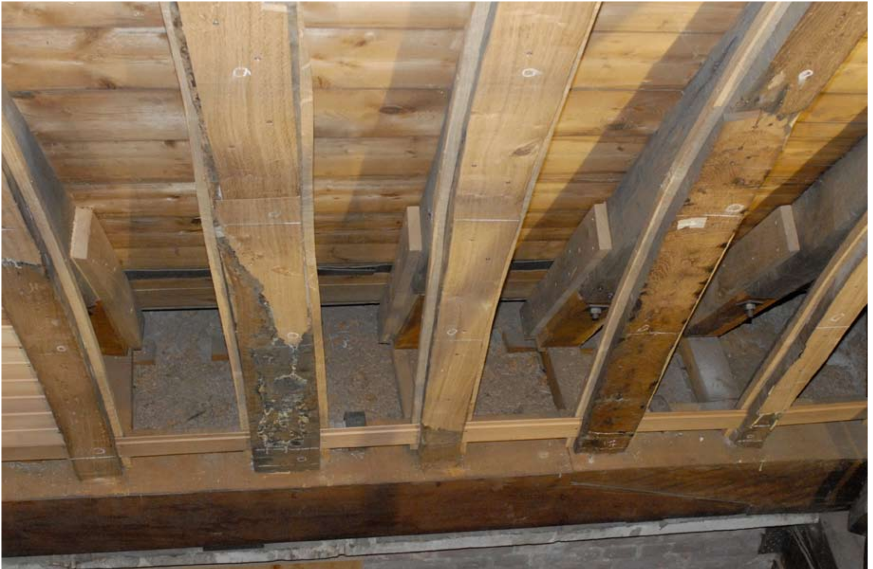
Afbeelding 65: Vak 6 met herstelde sporen en herplaatste standzoon-schenkels waartegen de eiken latten voor het tussen beschoot zijn geschroefd.
