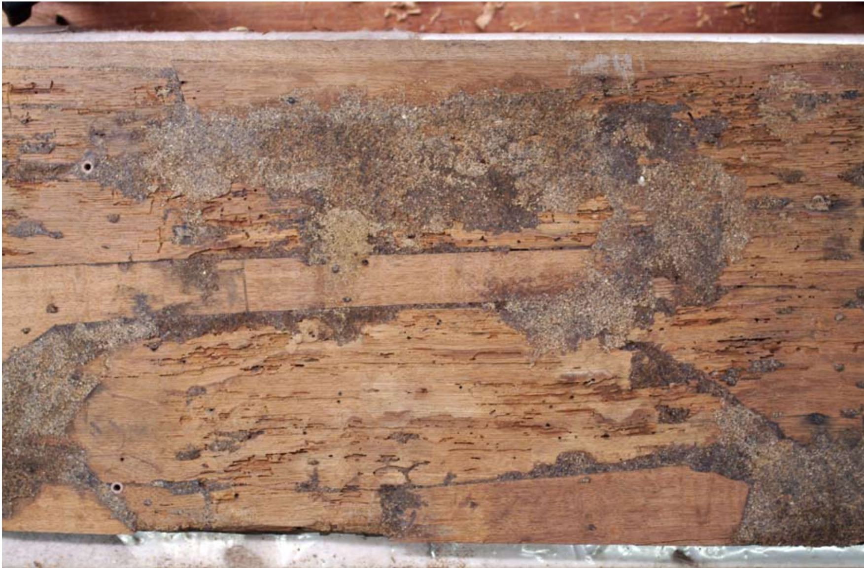
Afbeelding 15: Achterzijde van herstellende plank uit vak 7, met inzetstukken. De weggevreten gedeelten zijn weer opgevuld met zaagselplamuur.
