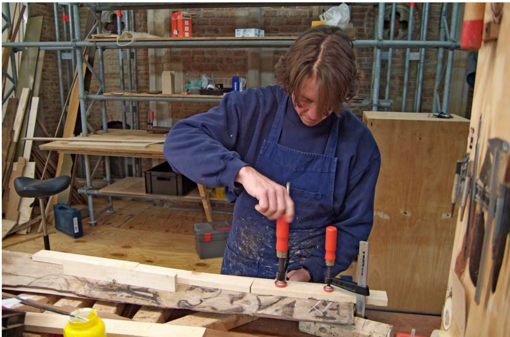
Afbeelding 43: Ramses Hertman herstelt het beschot uit het transept, brengt hier een lijmklem op spanning.
