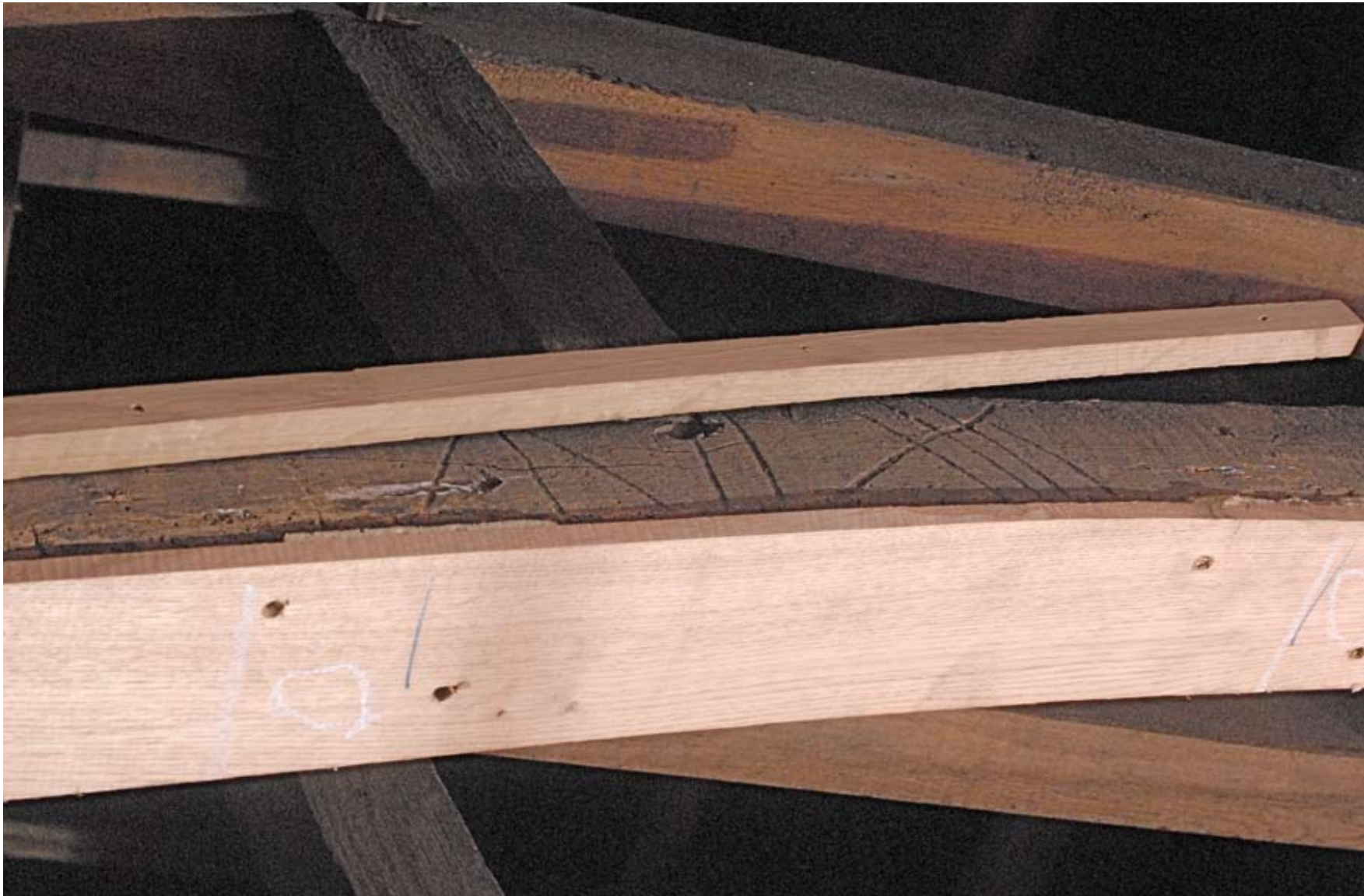
Afbeelding 60: Gewelfhout met vlotmerken. Op de zijkanten worden de eiken latten geschroefd waartegen het tussenbeschoot zal worden bevestigd.
