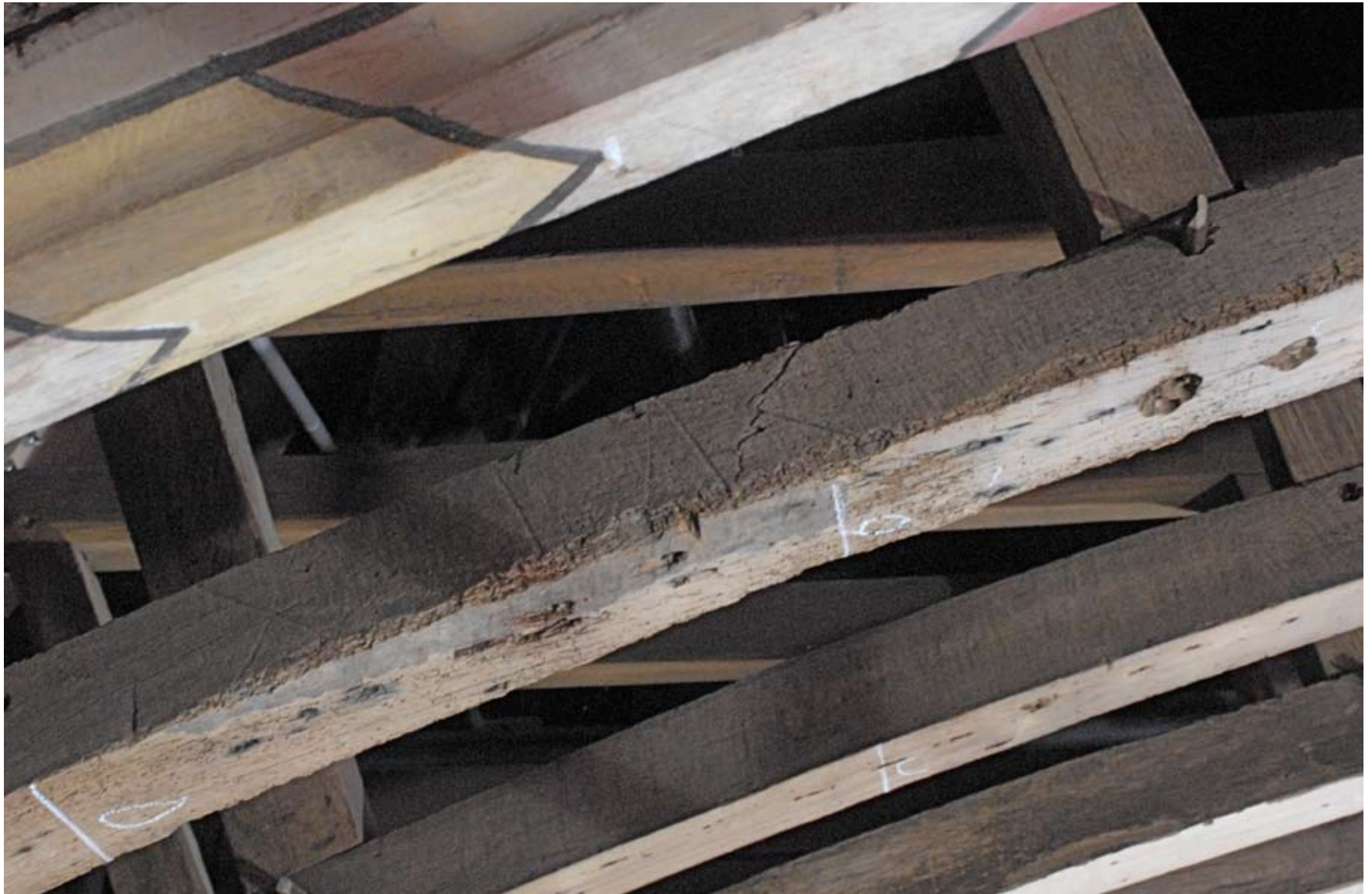
Afbeelding 59: Blik in de kap bij vak N3. Op de zijkant van de gebroken korbeelschenkel staan stukken van een vlotmerk.
