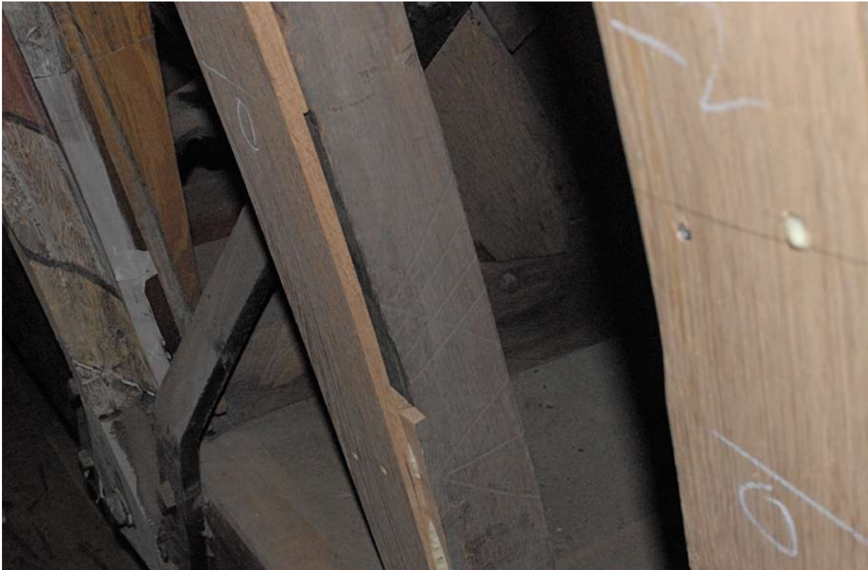
Afbeelding 62: Linker benedenhoek van vak N3, met het verschoven tussenspannt. De standzoon-schenkel van het gewelfhout is met een strook eikenhout verzwaaard terwille van het terug te plaatsen beschoot.
