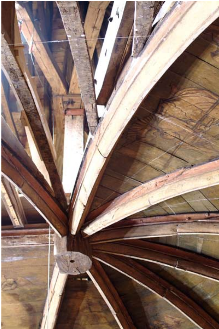
Afbeelding 67: Beschot uit vakken 7 en 9 gedemonteerd. Er worden nieuwe meetlijnen in de kap uitgezet om de op te zoeken spijkerposities in het gewelfhout exact te kunnen vastleggen (zie 2).
