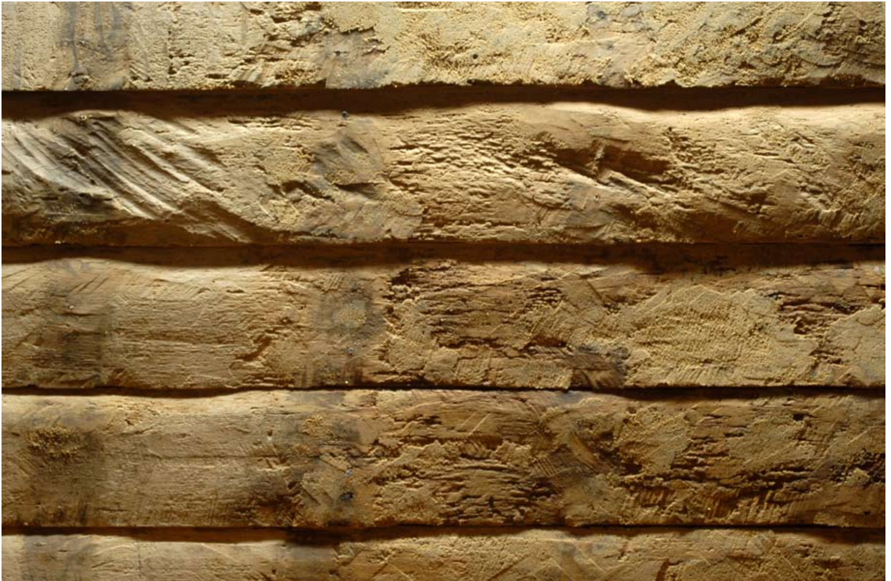
Afbeelding 70: Achterkant van het beschot met de door strijklicht verduidelijkte sporen van het zagen en kloven.
