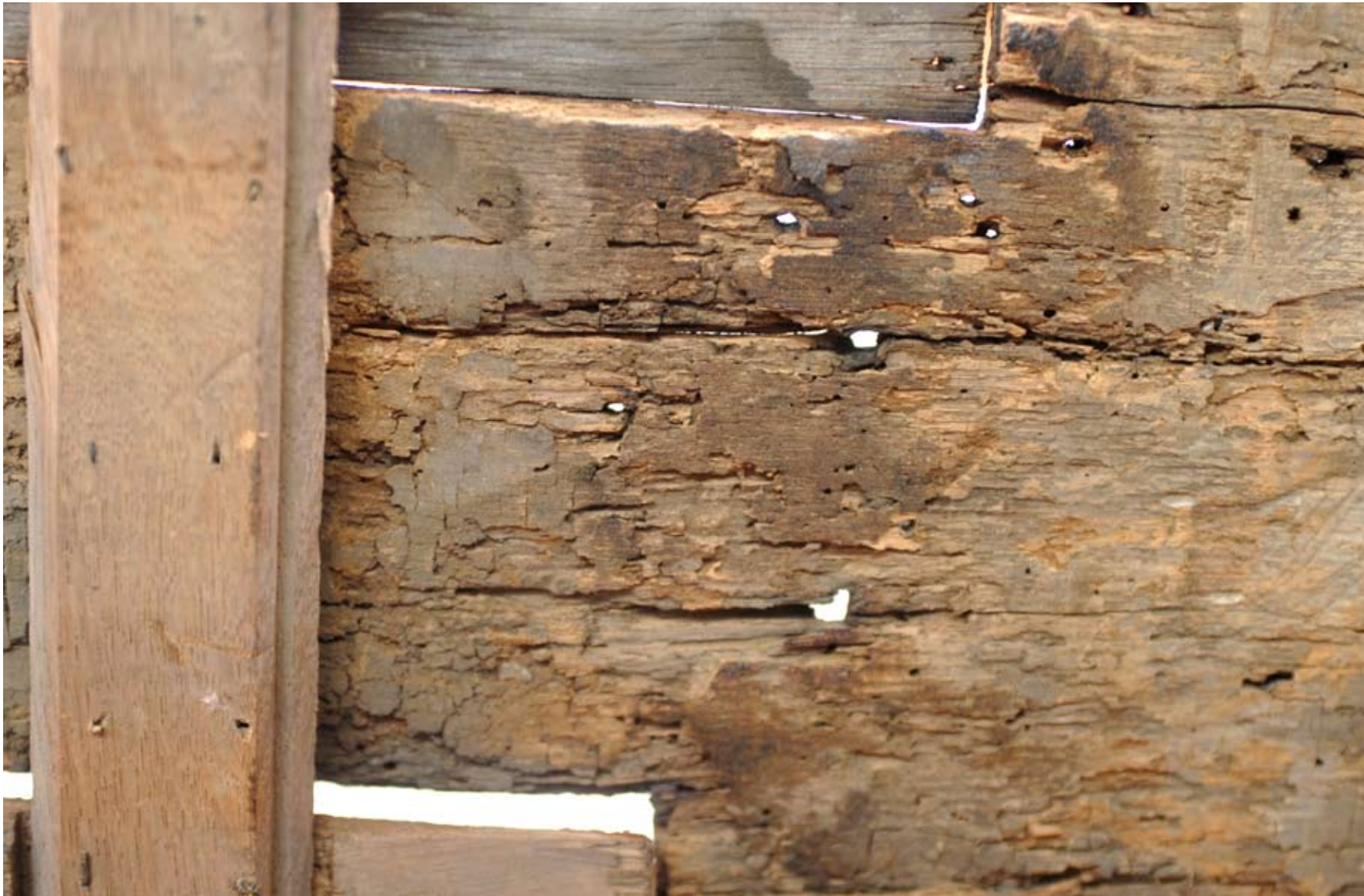
Afbeelding 9: Detail van de verzwakte planken uit vak 4.
