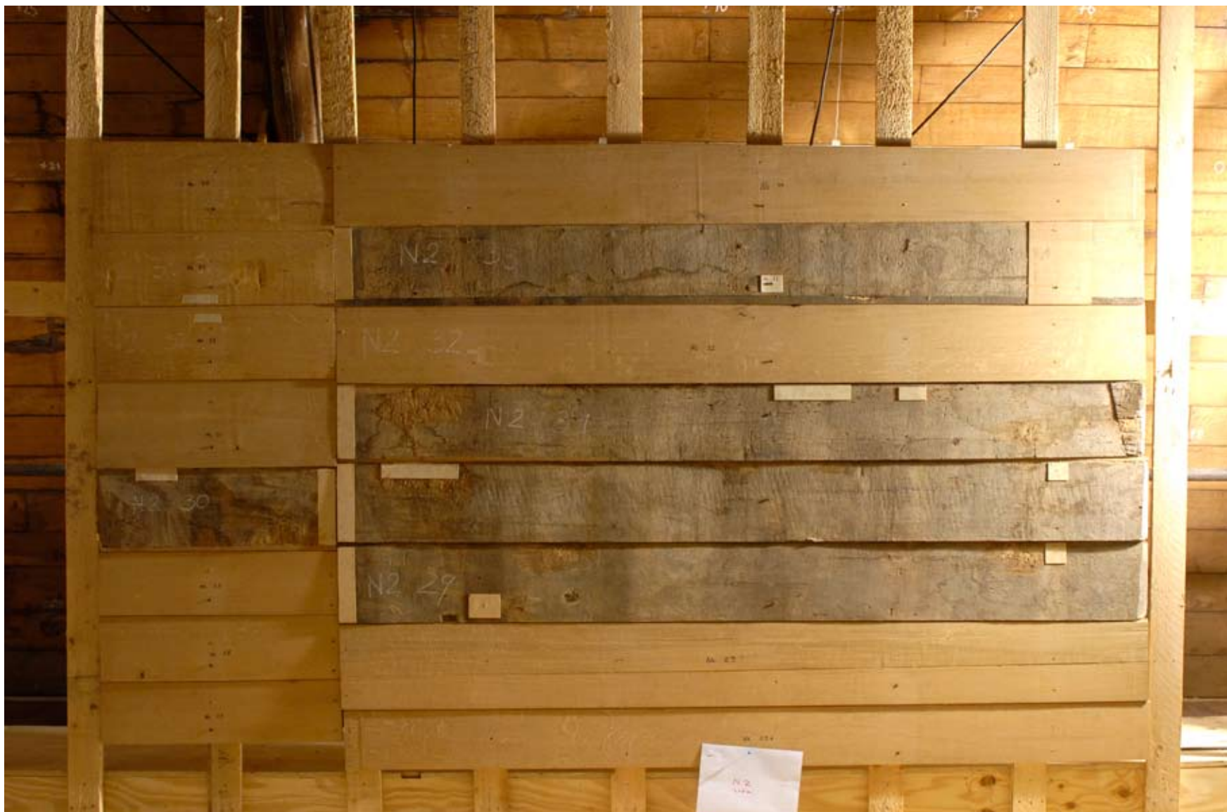
Afbeelding 54: Achterkant van vak N2. Opstelling op de steiger in het transept om de zaagsporen met strijklicht te bekijken en te fotograferen.
