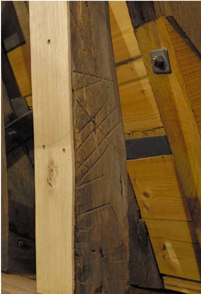
Afbeelding 64: Vak 6 in de koorsluiting met gecorrigeerde gewelfvoet. Standzoon-schenkel met deel van vlotmerk op de zijkant.
