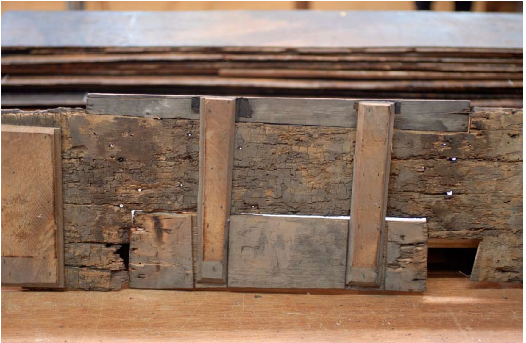
Afbeelding 6: Achterzijde van planken uit vak 4 met de aangespijkerde klampen er nog op (vergelijk met foto 14).
