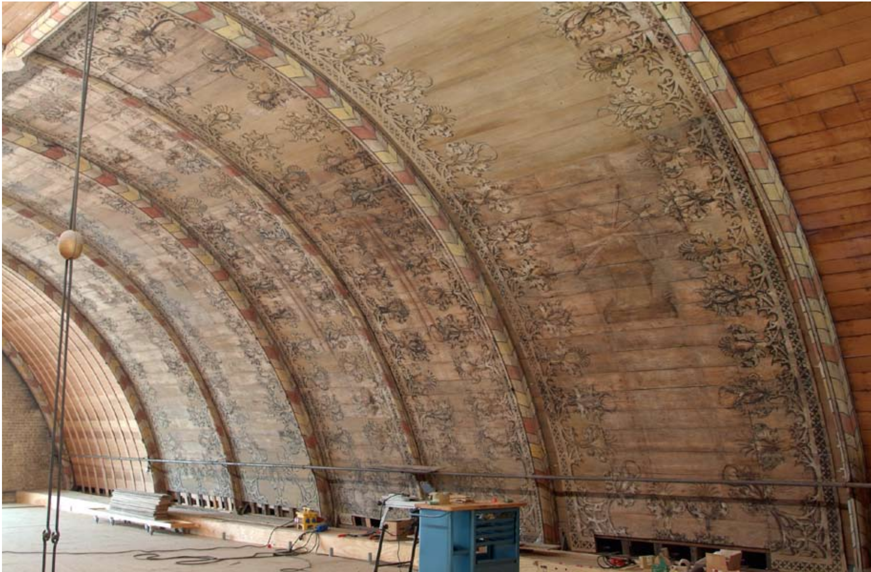
Afbeelding 50: Herfst 2006. De oostelijke vakken N2 tm N6 zijn na 120 jaar op hun plaats in de kap terug. Even later zal de oostelijke helft van de steigervloer worden gedemonteerd om het resultaat van alle inspanningen van beneden af te kunnen beoordelen.
