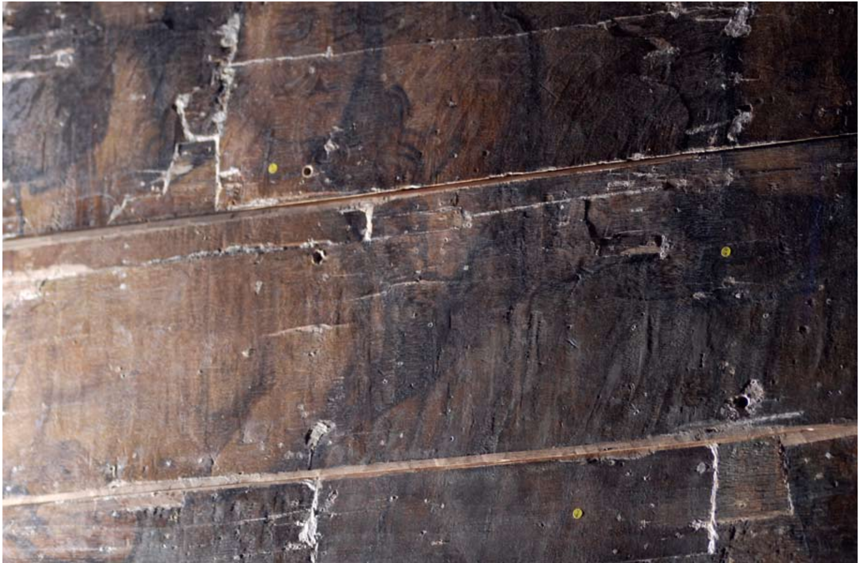
Afbeelding 14: Strijklicht op detail van vak 4 bij omkijkende vrouw. Planken hersteld, inclusief messing en groef. Vernis nog niet afgenomen.
