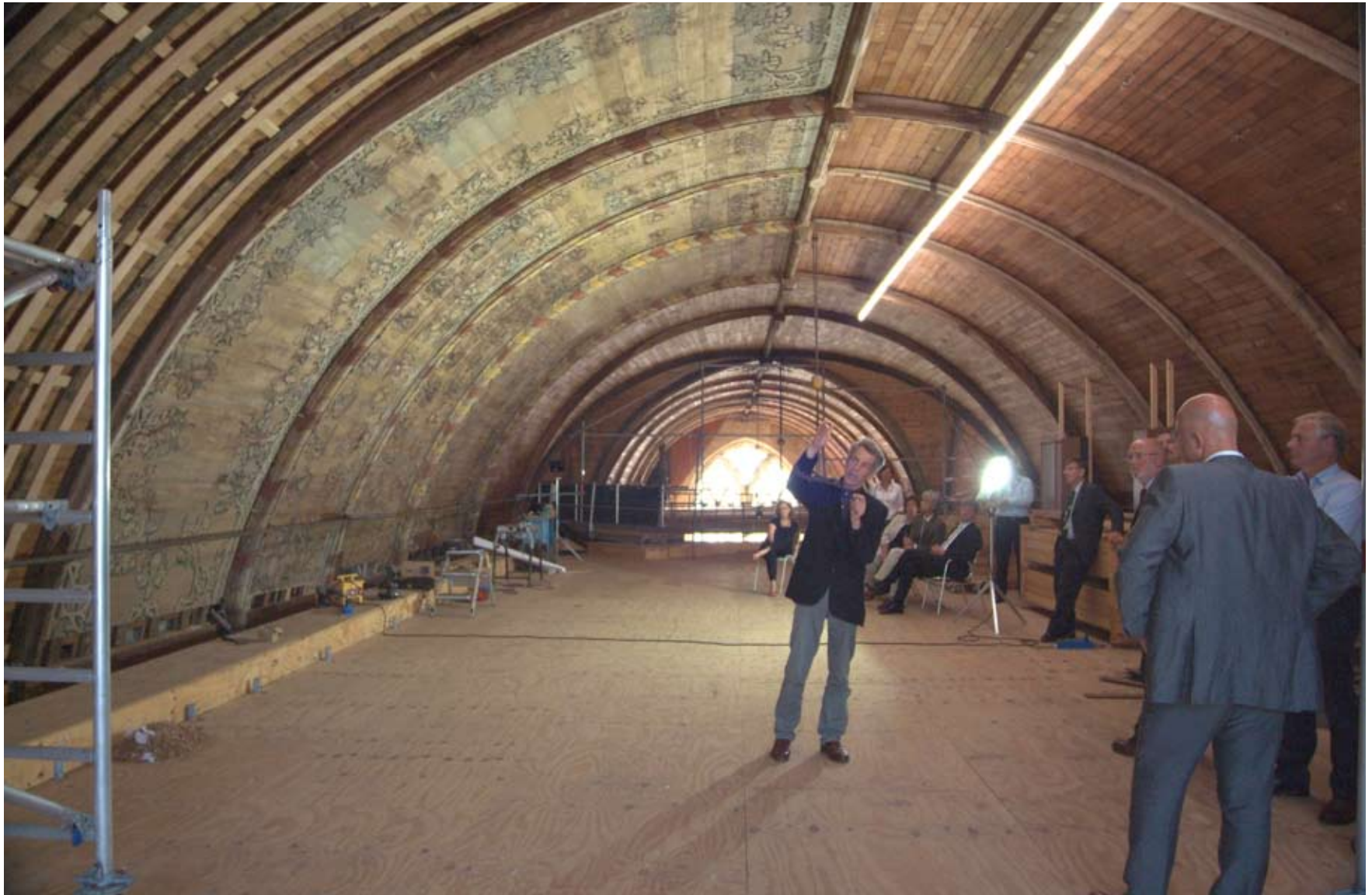
Afbeelding 74: Het bezoek is inmiddels op de steiger in het transept en kijkt naar de montagestroken op het nieuwe tussenbeschot in vak N7.
