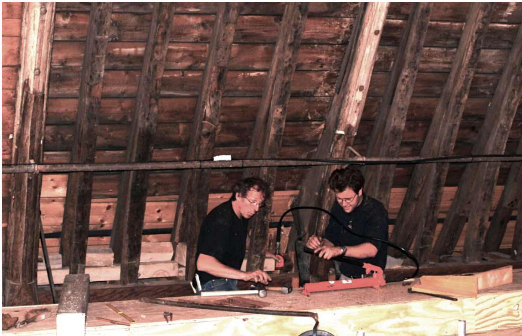
Afbeelding 58: Hydraulische verschuiving van het spant tussen de vakken N4 en N3 door Ed Kueter een andere stand-in poseren op zijn plaats.
