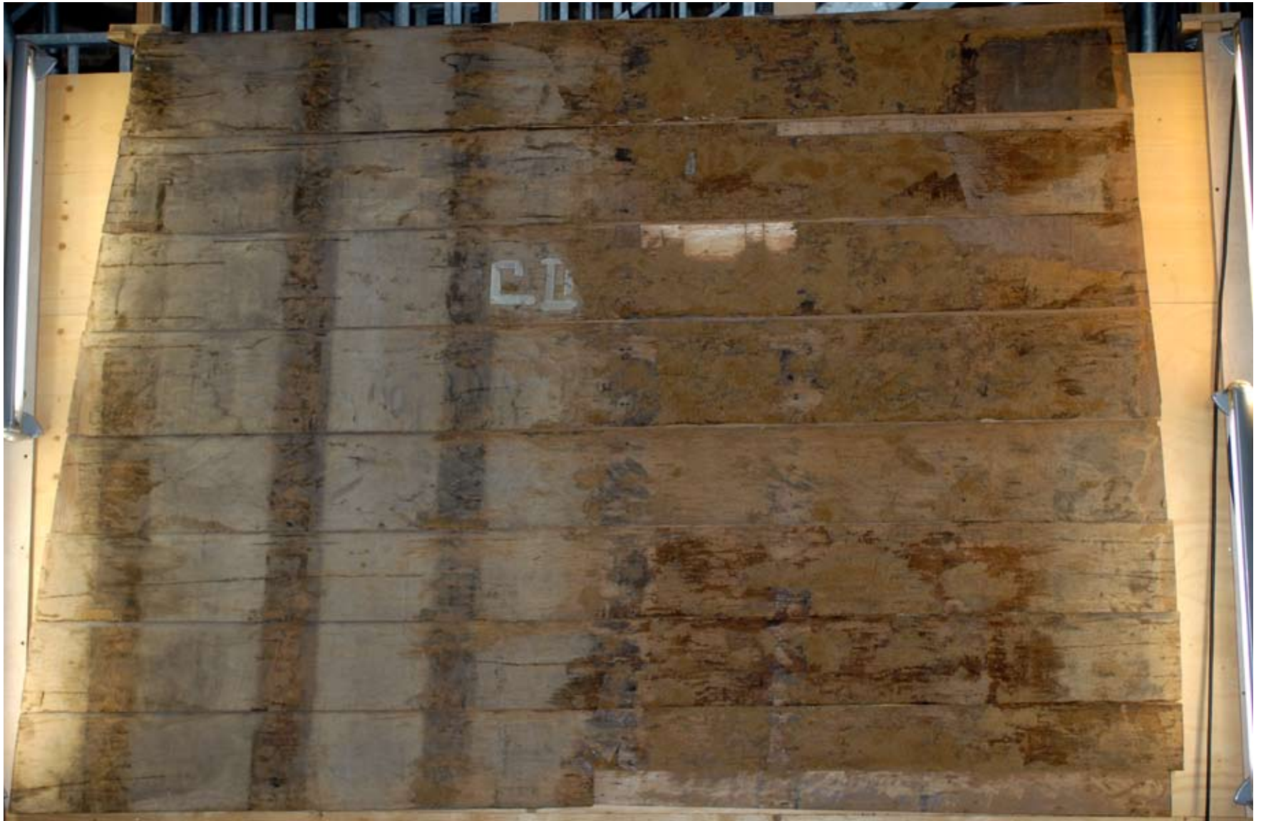
Afbeelding 16: Achterzijde van uitgenomen vak 6, in het houtatelier opgesteld voor bestudering bij strijklicht.
