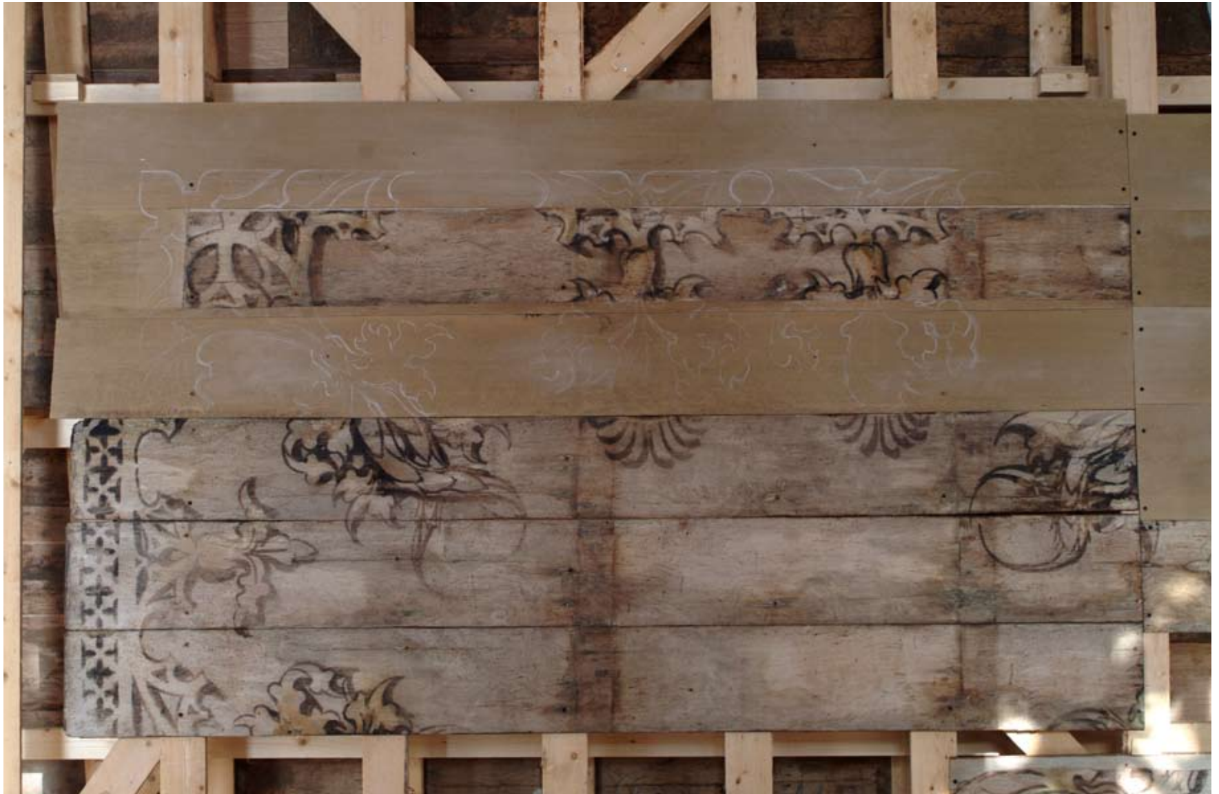
Afbeelding 51: Bovenkant van vak N2 op de bok. De kamversiering in krijt opgezet op de aanvullende nieuwe planken.
