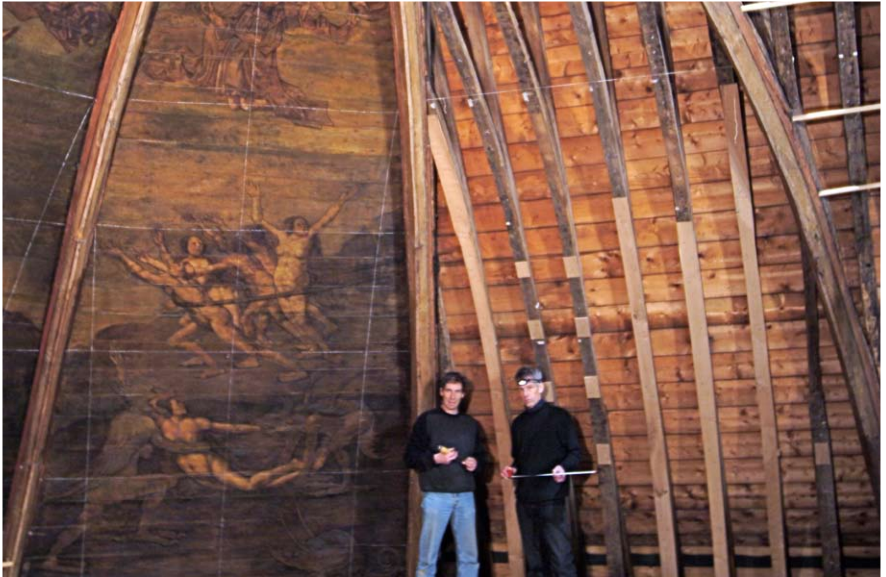
Afbeelding 2: Vakken 7 en 9 (Hellekant) gedemonteerd. Gewelfhout in het zicht. WHW zet nieuwe meetlijnen uit om de op te zoeken spijkerposities in het gewelfhout exact te kunnen vastleggen.
