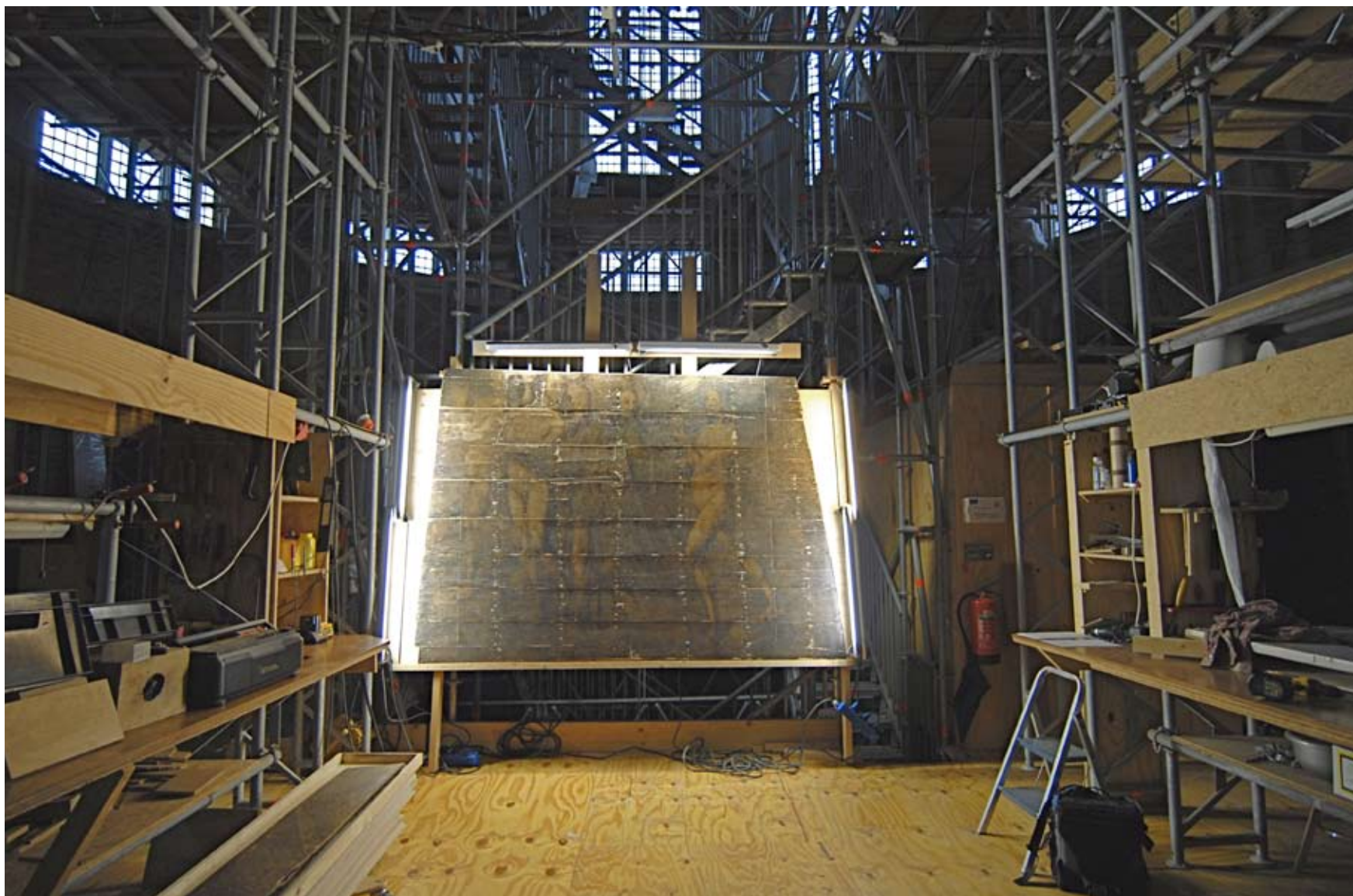
Afbeelding 69: Benedenhelft van vak 4, na herstel van de messing-en-groefverbindingen, opgesteld in het houtatelier ter bestudering van het oppervlak met strijklicht door Edwin van den Brink.
