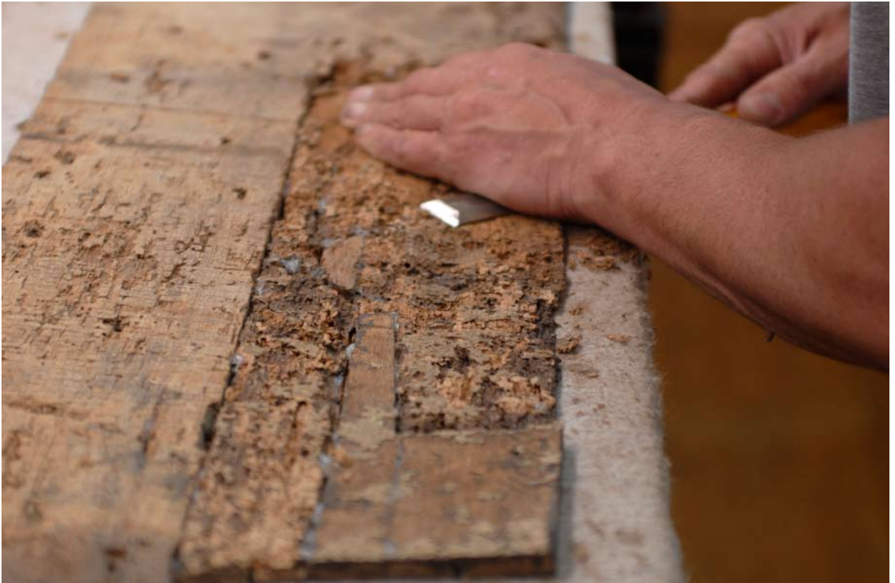
Afbeelding 8: Herstel van de achterkant van een aangetaste plank met ingelast stuk uit vak 4.
