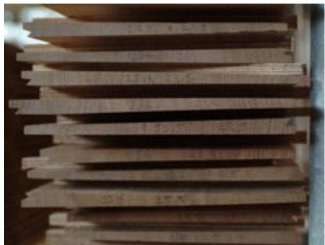
De tapse vorm van het wagenschot
