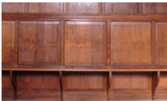
Boven: wagenschot planken van de 17de eeuwse banken Onder: kopse kant van het wagenschot met mergstralen en jaarringen
