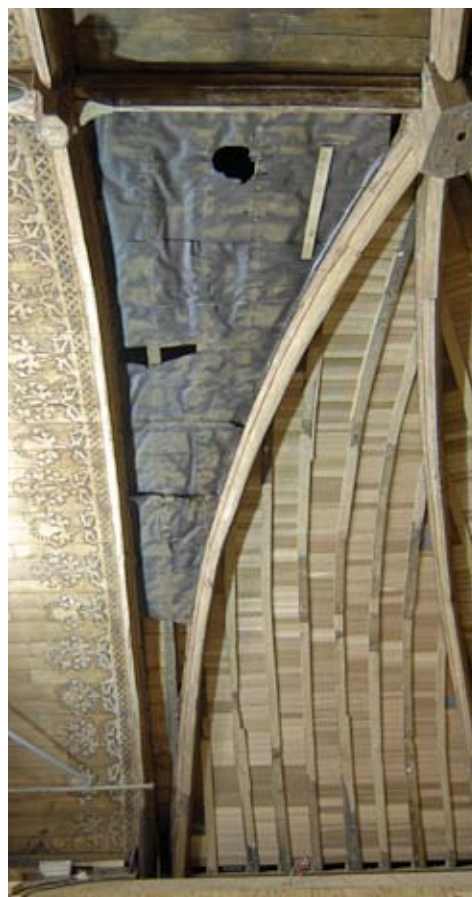
Vak 7 en 9 gedemonteerd asfaltpapier en tussenbeschoot
